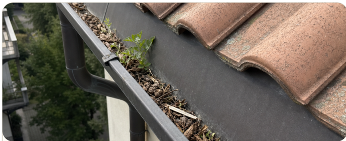
P01 - Gronda lato nord
